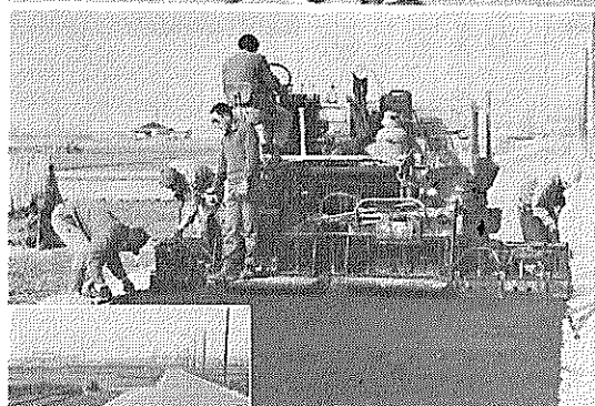
◇草内馬橋線の 舗装なる
